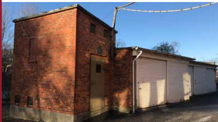
Transformerstation og garageanlæg
