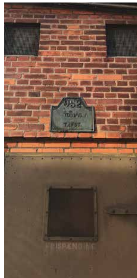
Transformatorstation, Tobias Jensen, Kirkebjerg Parkvej 4
